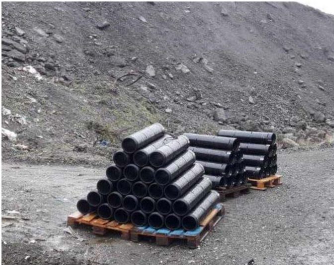
Relining-Rohre für den „Normaleinsatz“ in einer Deponie und bei extremen chemischen Angriffen
