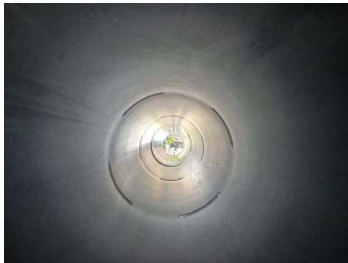
PE-Innenseite der Relining-Rohre
